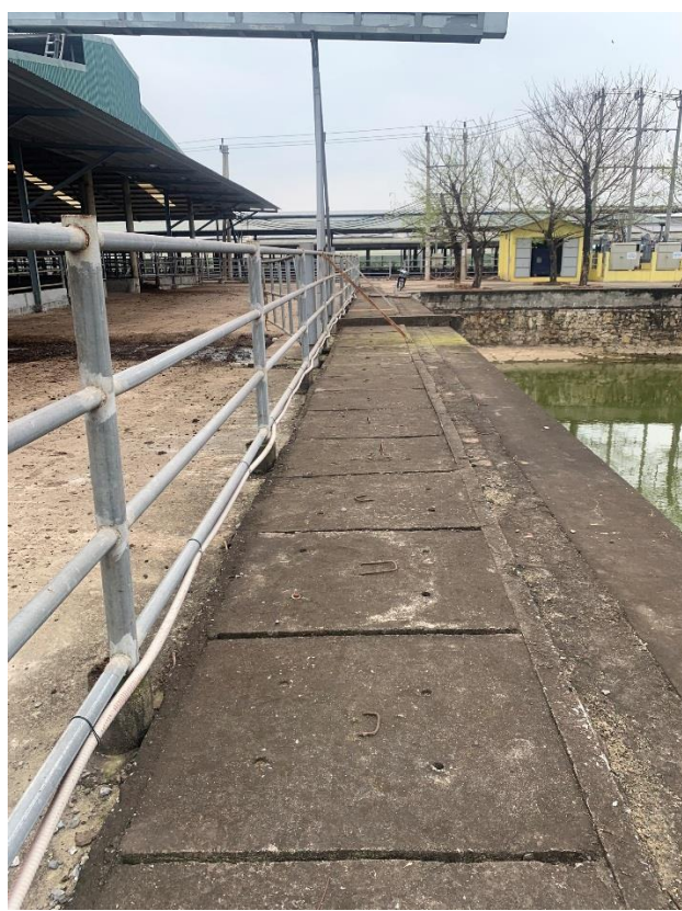
Hình 3.4. Mương thu gom nước thải
