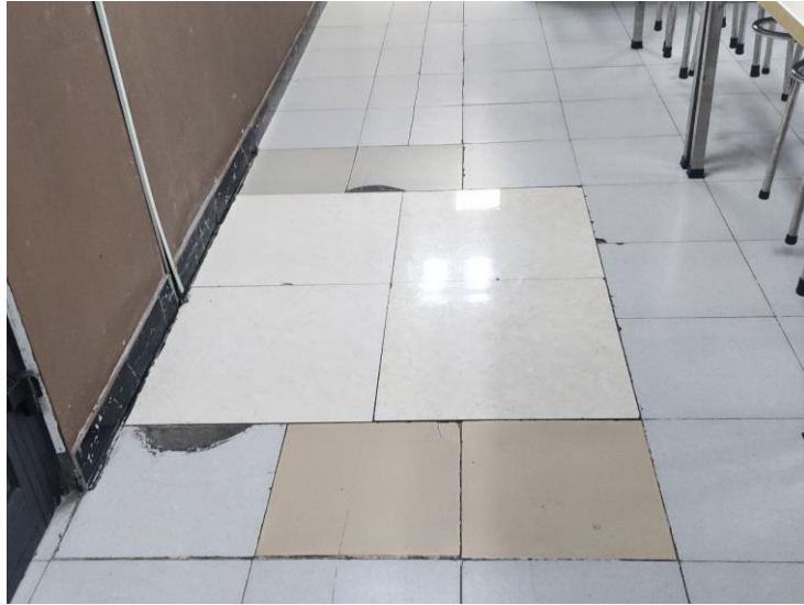
Hình ảnh: Vị trí đặt bể tách dầu mỡ tại khu vực bếp tầng hầm B2
