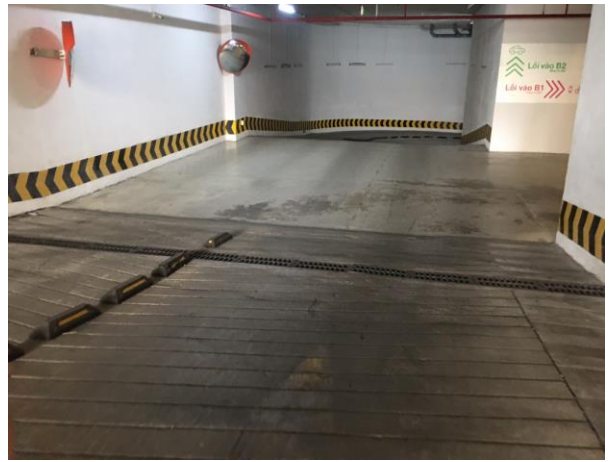
Hình ảnh: Mương thu nước mưa cuối ram dốc ở tầng hầm
