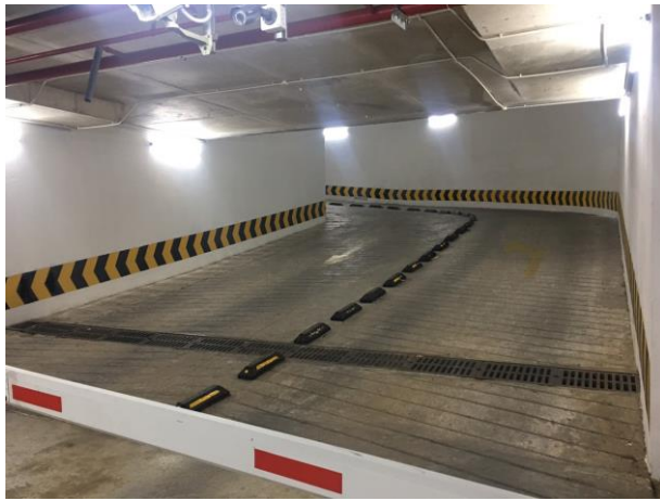
Hình ảnh: Mương thu nước mưa cuối ram dốc ở tầng hầm
